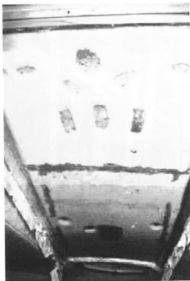
Första lagret på plats, notera urtag för beslagen.
