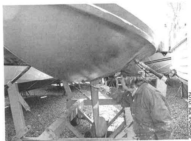
Innan målning se till att ytan är riktigt slät
